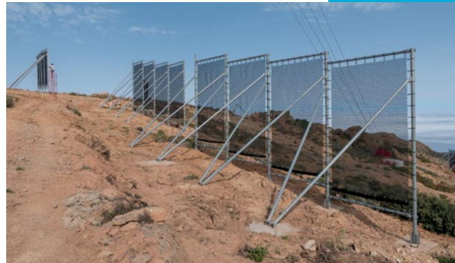
CloudFisher-Nebelkollektoren sammeln energie- und wartungsarm hochwertiges Trinkwasser
