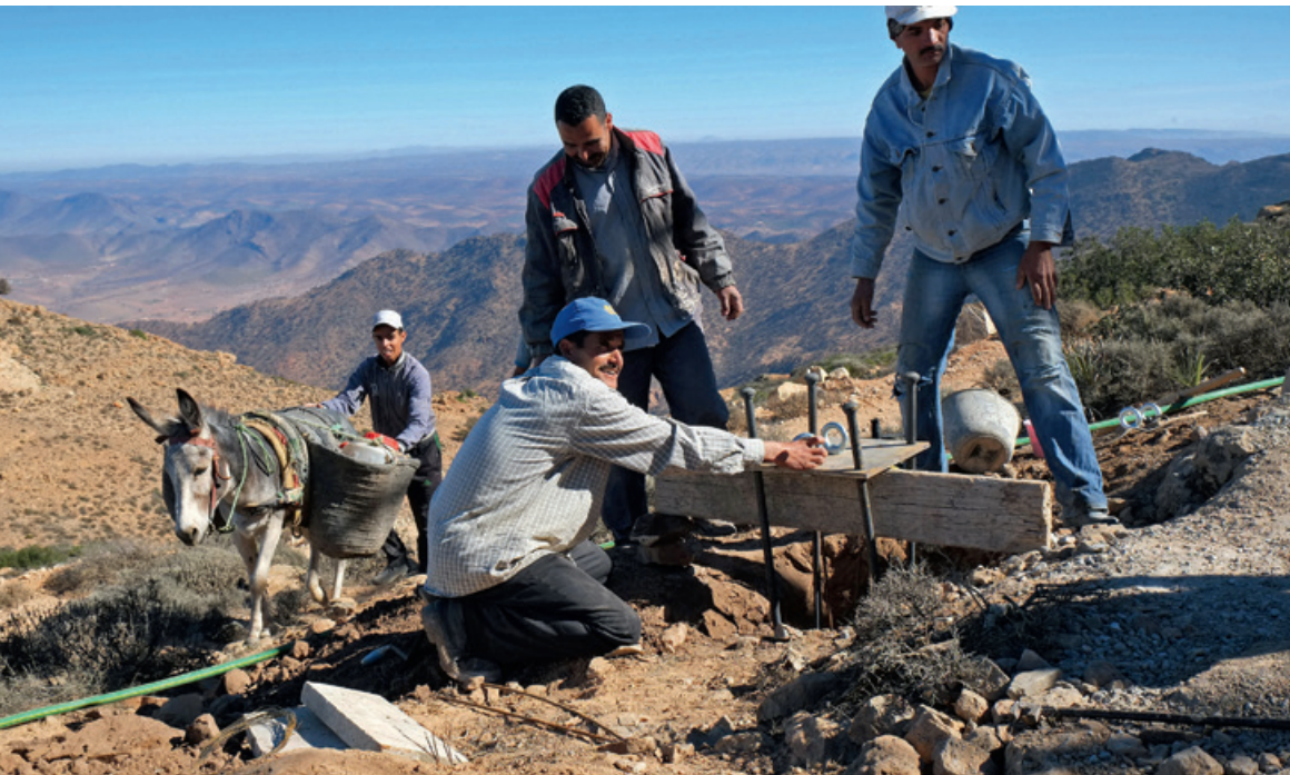
Abb. 3: Mit nur zwei Werkzeugen kann der CloudFisher innerhalb kürzester Zeit aufgebaut werden.
