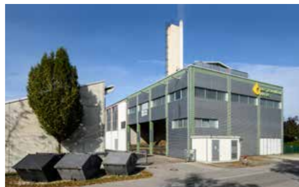
Die Heizzentrale der Gemeindewerke Ainring gibt es schon seit den 70er-Jahren im Ortsteil Mitterfelden.
