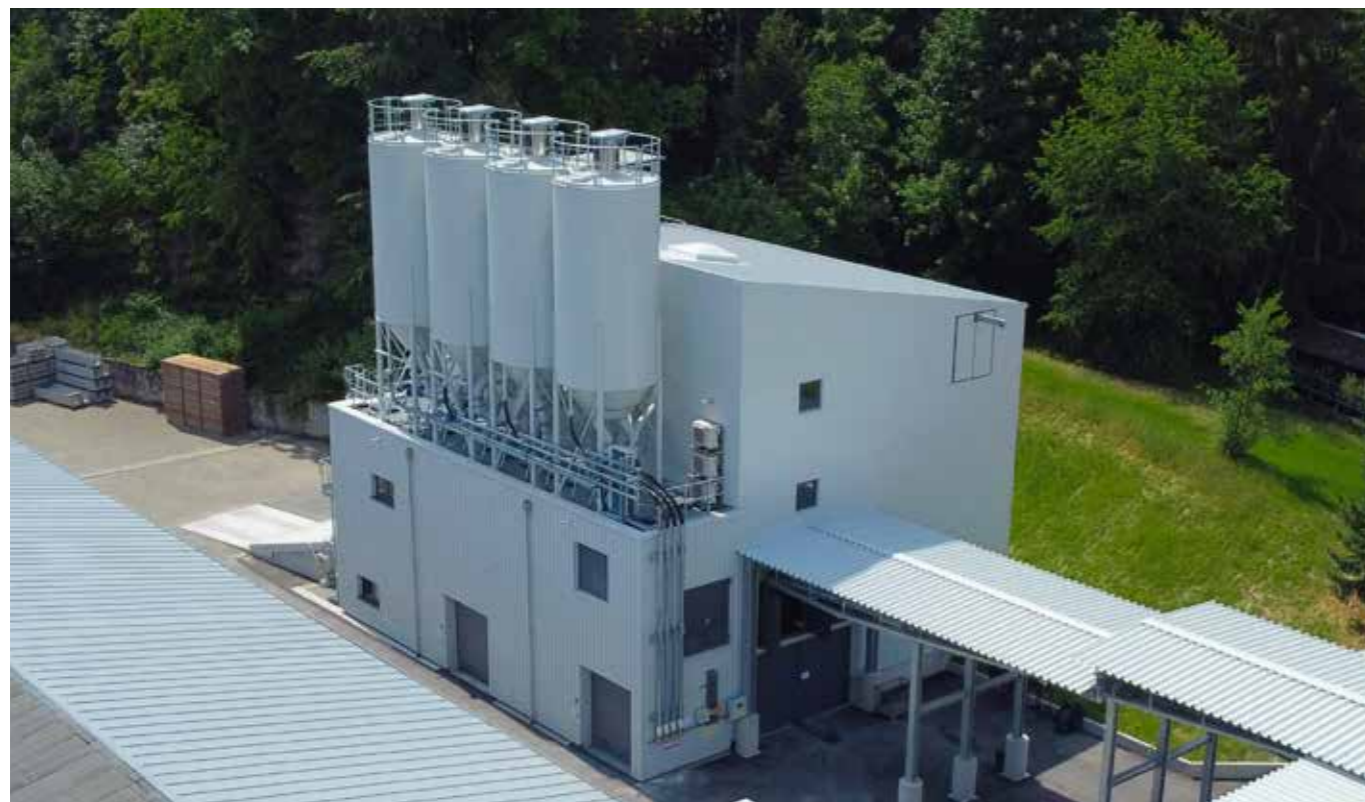
Durch die vier Zementsilos und weiteren Zuschlagsilos werden Kapazität und Flexibilität deutlich erhöht.
