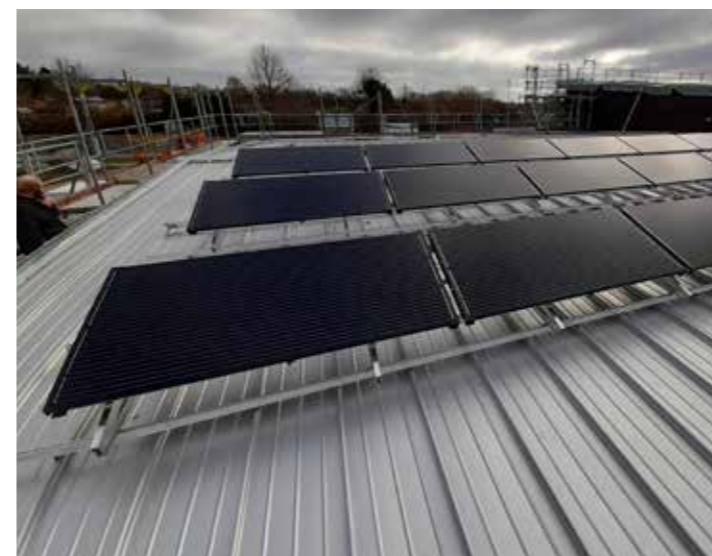
Abbildung 2: 20x PVT-Module (Modulfläche 2 m²). Bildquelle: Stadtwerke Schleswig.
