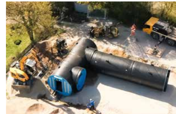
Versetzen des PE-Behälters auf der Baustelle
