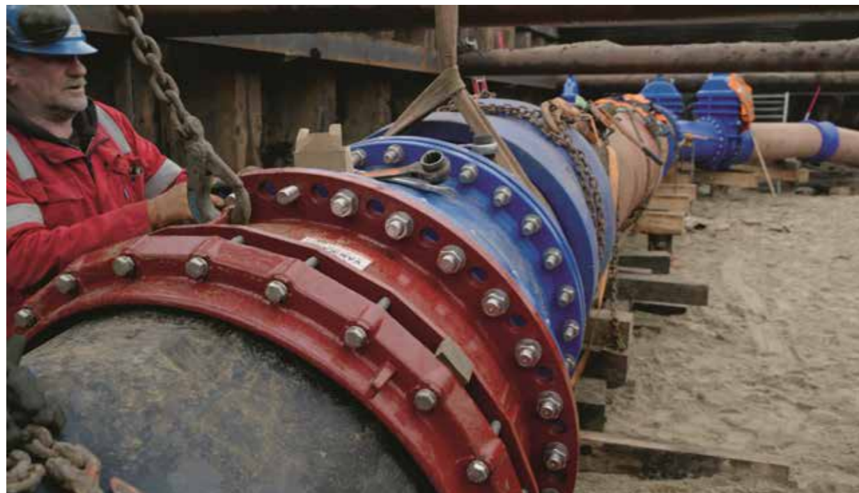
Die zuverlässigen MULTI/JOINT Großkupplungen sind jetzt bis zur Dimension DN1025 verfügbar.
