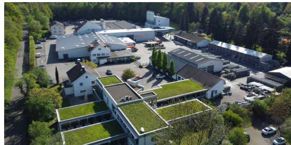
Die neue Mischanlage (rechts hinten im Bild) ermöglicht direkt am Standort eine effizientere, flexiblere und nachhaltigere Produktion von Frischbeton für die BIRCO-Rinnenkörper.
