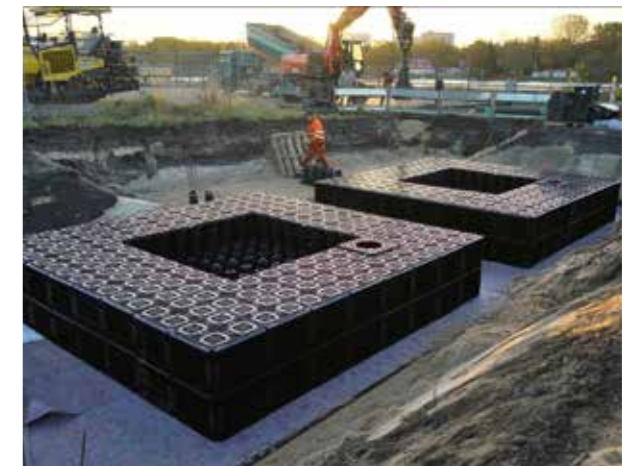
ACO Stormbrixx Elemente als Baumrigole, die als Wurzelraum dienen und mit einem speziellen Substrat gefüllt werden.
