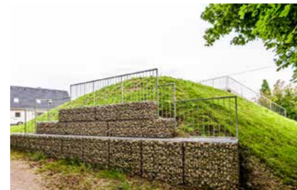
Außenansicht nach Fertigstellung
