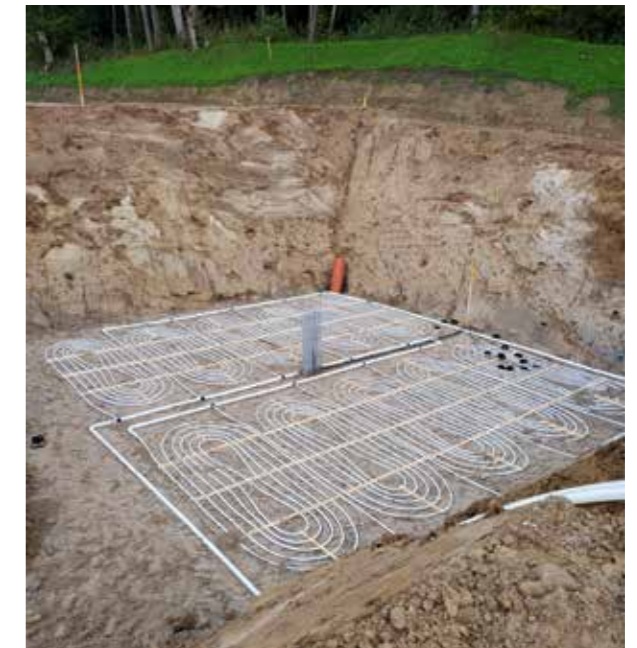
Abbildung 3: unterste von insgesamt 4 Ebenen des Erdeisspeichers. Bildquelle: FAU Erlangen
