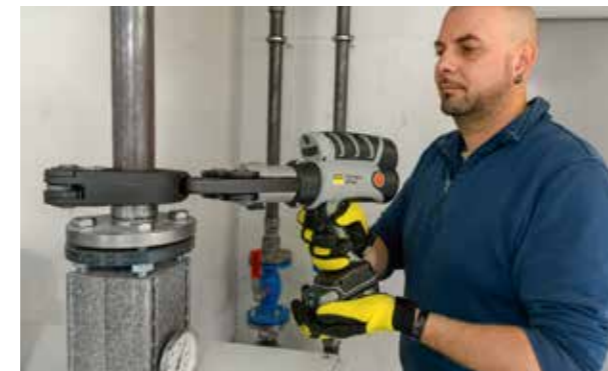
Stefan Mühlbauer von den Gemeindewerken Ainring schätzt das unkomplizierte Arbeiten mit dem „Megapress S“-System und den abgestimmten Presswerkzeugen und -maschinen: „Im Gegensatz zum Schweißen gibt es keine Nebenarbeiten, und es geht alles wesentlich schneller und sicherer.“
