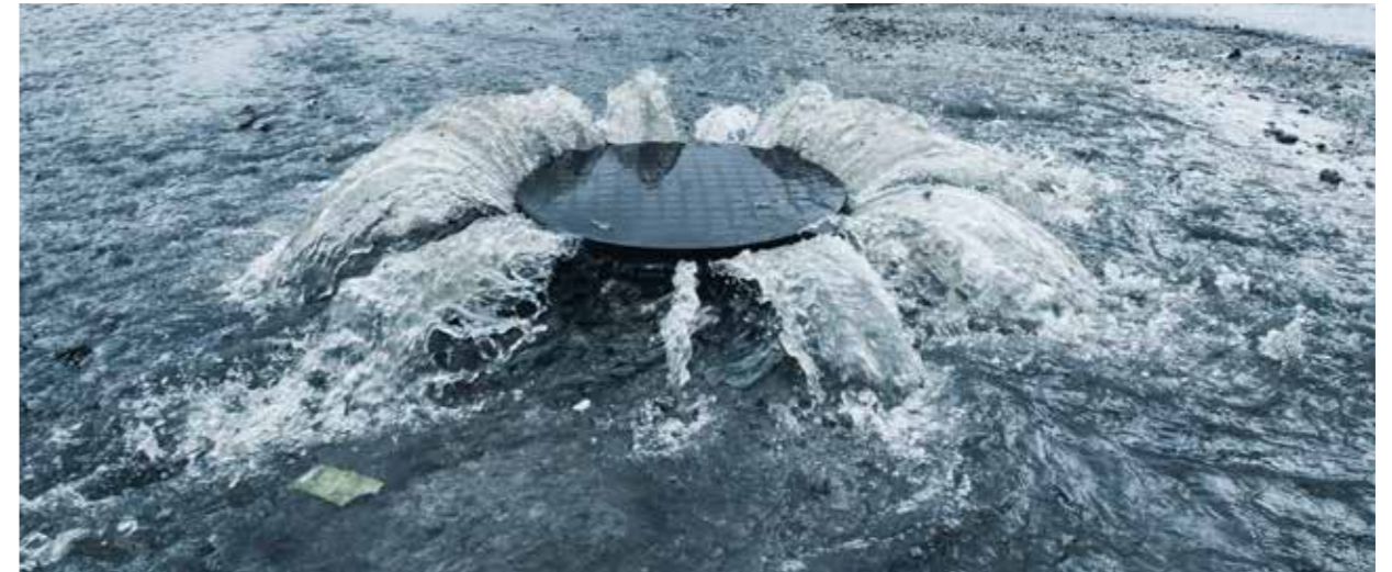
Überlastete Kanalsysteme bringen Gefahren wie beispielsweise Überschwemmungen mit sich.
