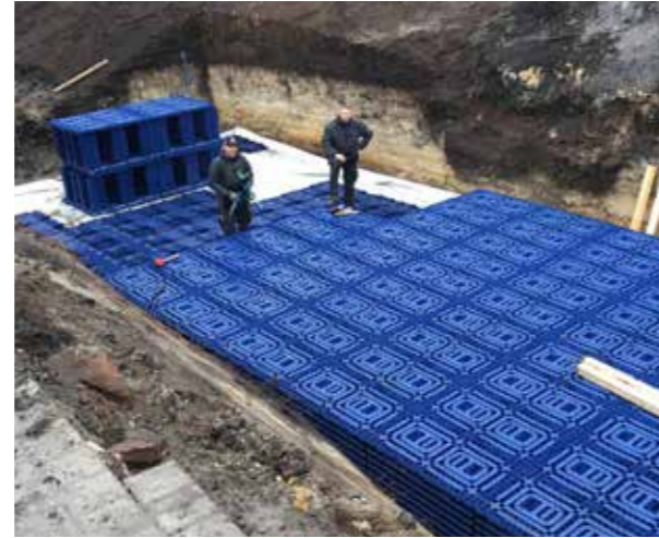
Aufgrund der integrierten Verbinder ist der Einbau schnell und sicher.
