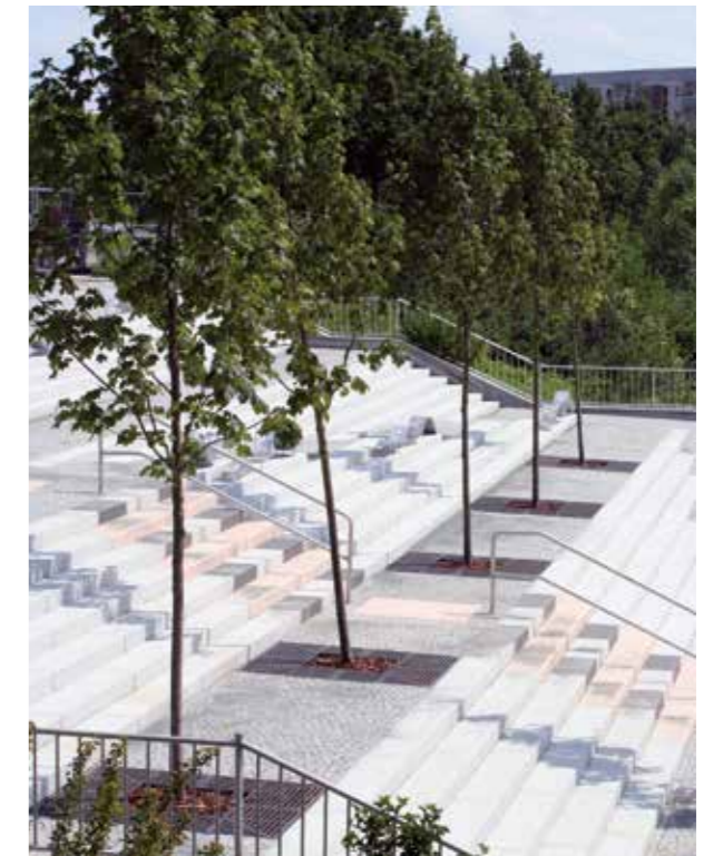
Zur optimalen Versorgung von Stadtbäumen verfolgt ACO einen ganzheitlichen Ansatz.
